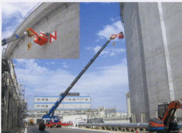
LNGタンク看板作業 半径25m 50Tラフター
