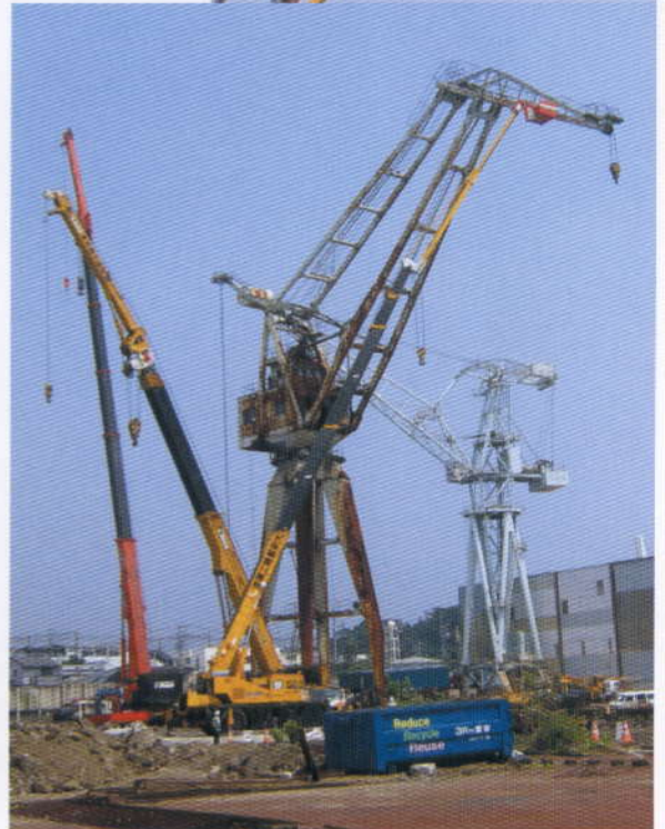
造船所クレーン解体 50m作業 50Tラフター
