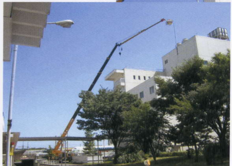
ビル避雷針交換 半径30m作業 50Tラフター
