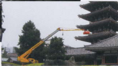
五重塔メンテナンス 50m作業 60Tラフター
