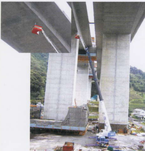
高速道 橋桁点検 40m作業 50Tラフター
