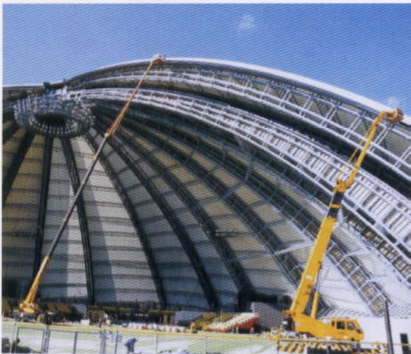
ドーム塗装 55m作業 50Tラフター
